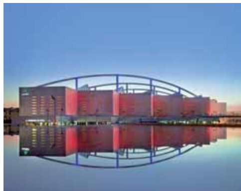
NOVA ARQUITECTURA A SARAGOSSA, ESTACIÓ DELICIAS.
