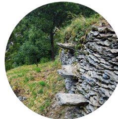
Escales de pedra seca
