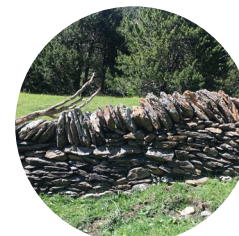
Mur de pierre sèche
